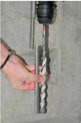
5a. ábra Fúrési mélység beállítása
